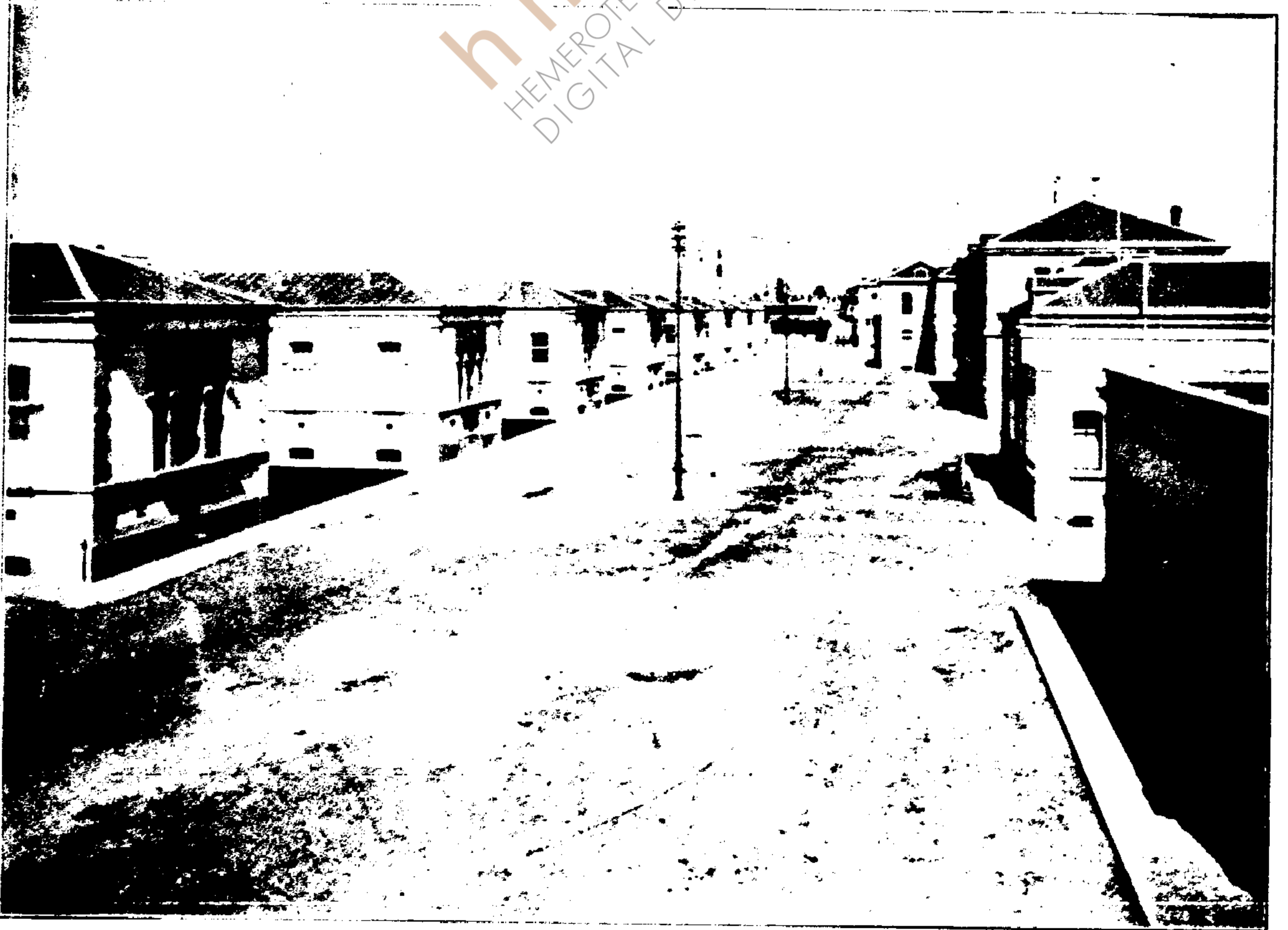
HOSPITAL GENERAL - CALLE PRINCIPAL DEL DISTRITO - CASA DE S. R. - CALLE
